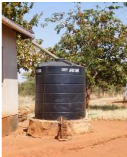
Vattentank för insamling av regnvatten
