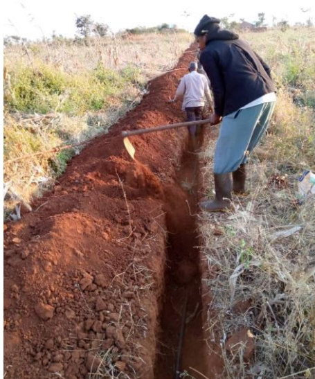
Vattentillgången är tillfälligt bättre vid sjukstugan då ledningarna reparerats
